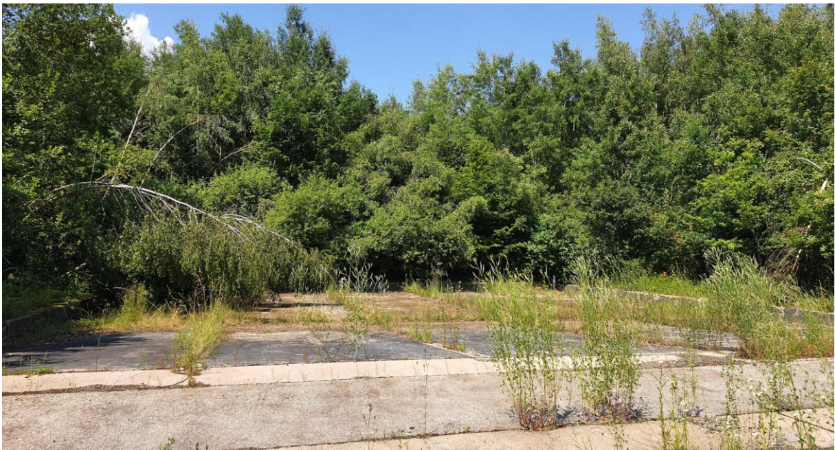
Abbildung 37: Betonbecken 4 mit wenig Vegetation, Jost 2024
