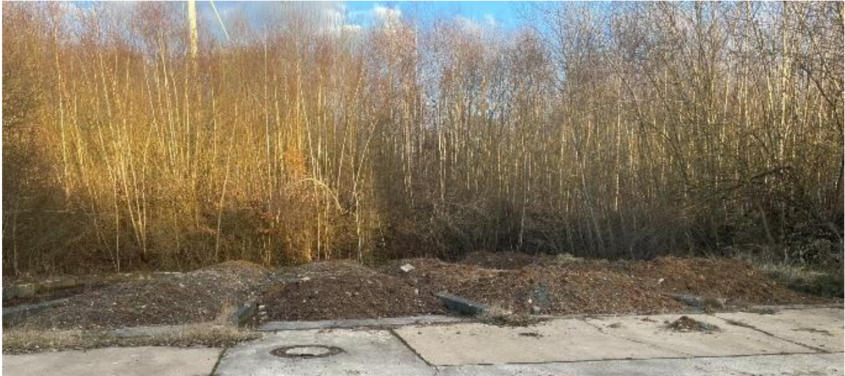
Abbildung 35: Betonbecken Nr. 3 mit Erdmaterial, Kraus 2025
