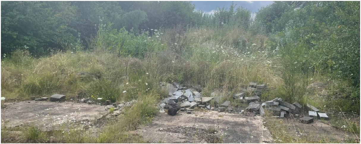
Abbildung 36: Betonbecken mit Erd-/Bauschuttmix, Kraus 2025
