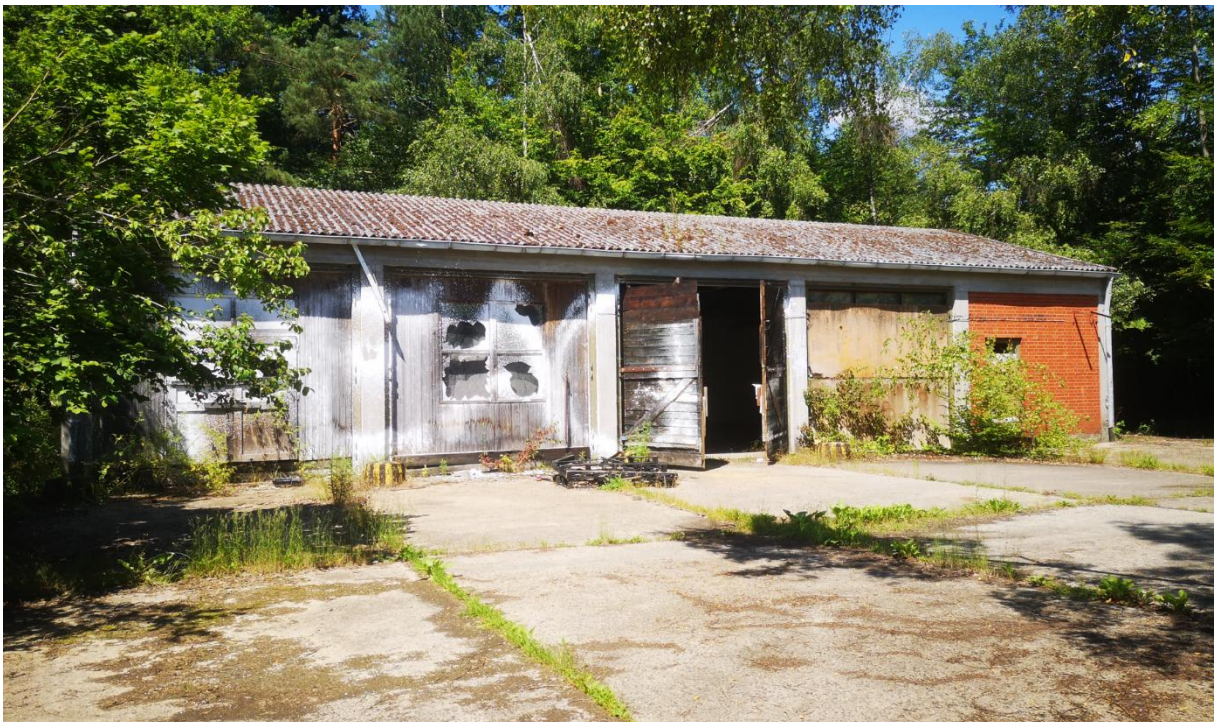
Abbildung 41. Ehemalige Halle für LKW + Brandschutzfahrzeuge, Kraus 2024
