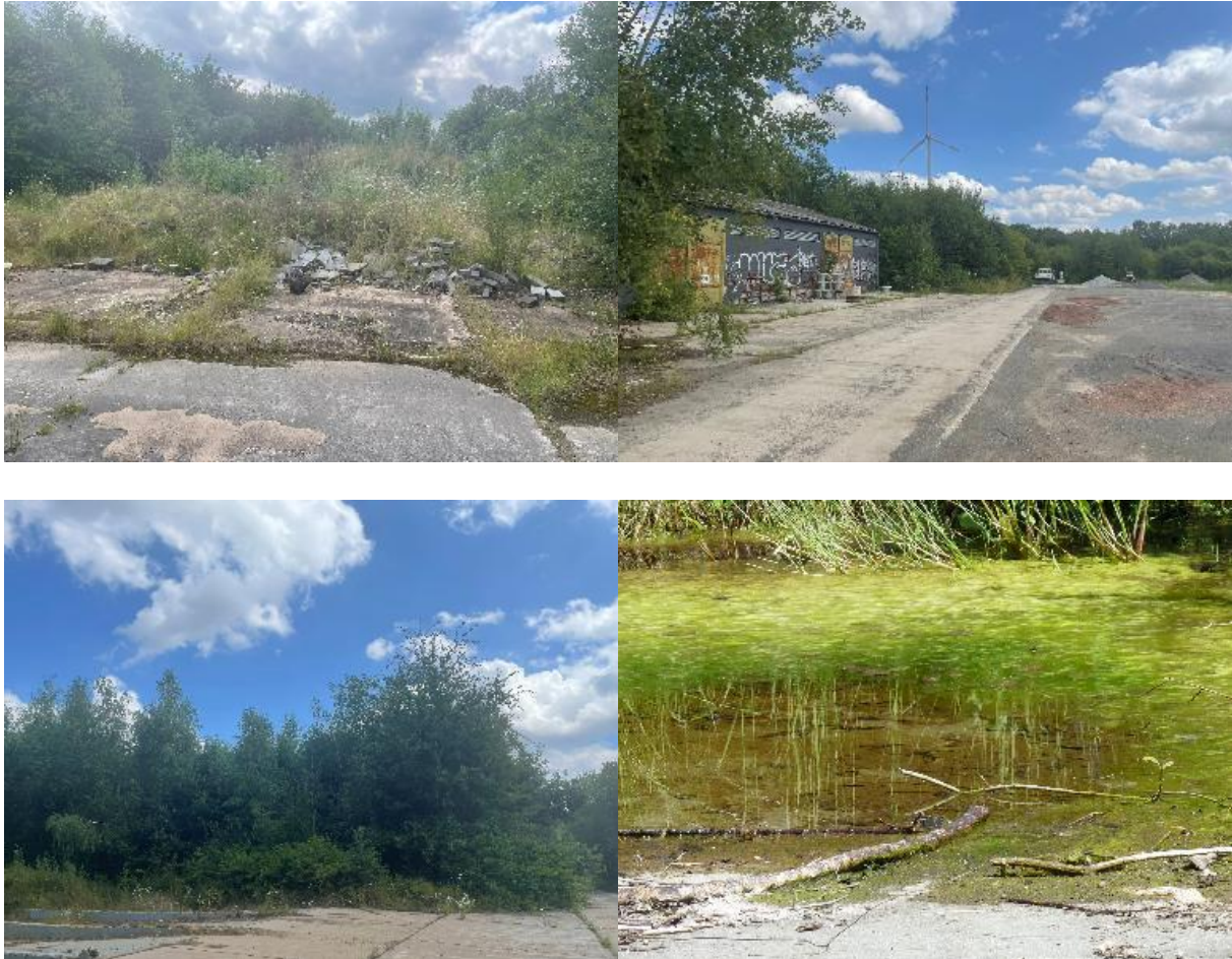
Abbildung 4: Foto 1: Ablagerungen auf Betonfläche, Foto 2: Halle mit Lagerflächen, Foto 3: Pionierwaldfläche, Foto 4: Wasserflächen auf Betonuntergrund, Kraus (2025)
